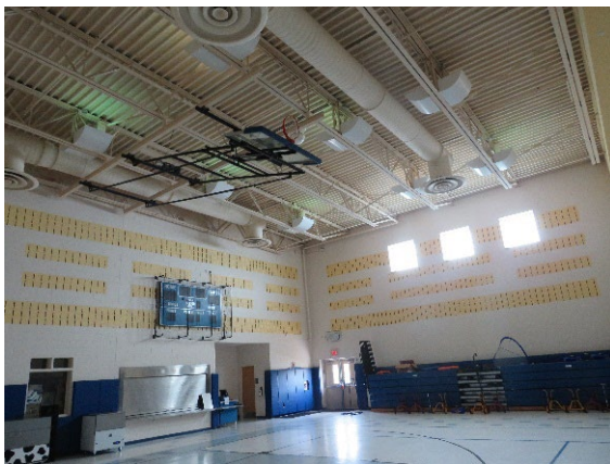
E. H. Slaybaugh PS - Multipurpose Room
